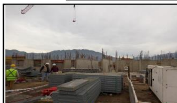
FOTOGRAFIA 11: Moldajes losas
