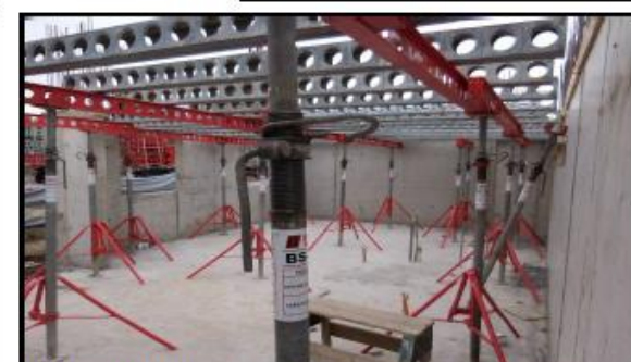
FOTOGRAFIA 12: Instalacion alzaprimas primera losa
