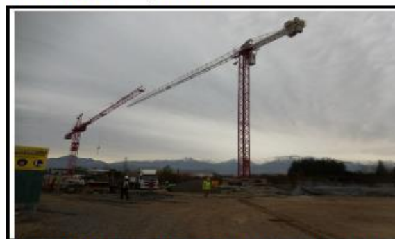
FOTOGRAFIA 13: Colocacion en operación de 2da grua
